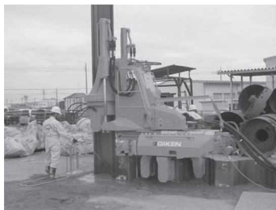
写真2 鋼矢板の打設状況 Photo 2 Piling by silent piler
